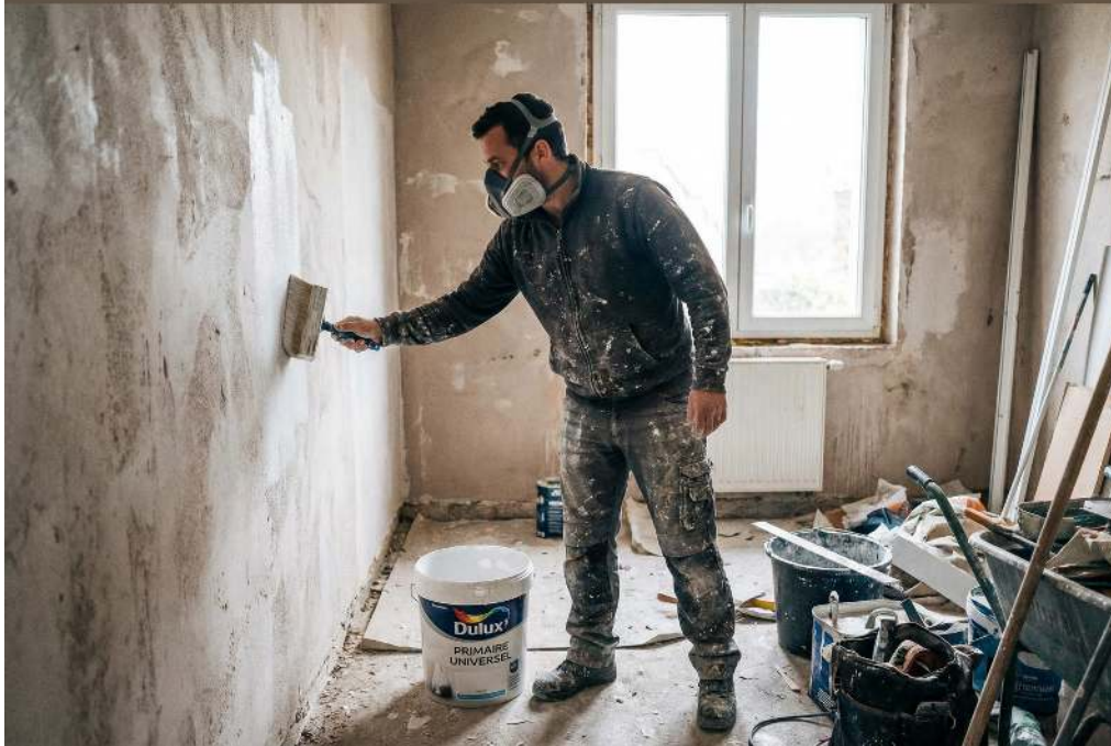
Application d'un primaire d'accrochage, temps de séchage 4 heures
