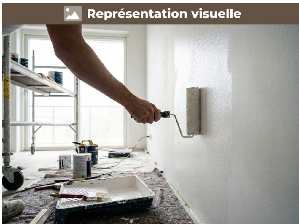
Application d'une couche de peinture, rendement de 10 m 2 par litre
