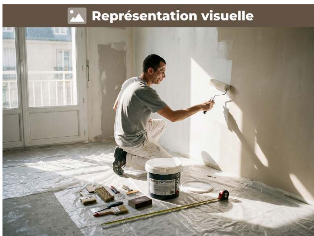
Application d'un primaire d'accrochage, temps de séchage 4 heures avant peinture
