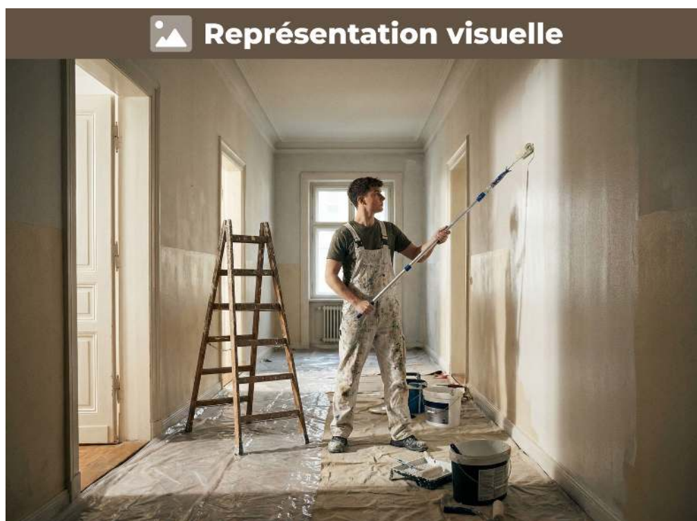
Réalisation de deux couches de peinture dans le couloir
